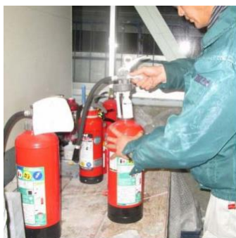
消火設備のメンテナンス
